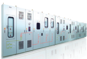
配電盤 SWITCHGEAR & CONTROLGEAR
