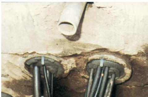
配電室地板管口防水處理
