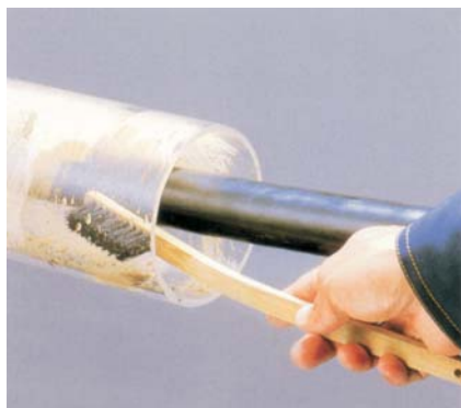
1. 管道及電纜的清潔
