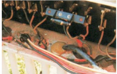
電線管及端子板之防水處理
