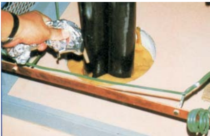
配電室地板管口防水處理
