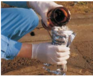
將水加入袋中至包紮帶完全浸濕
