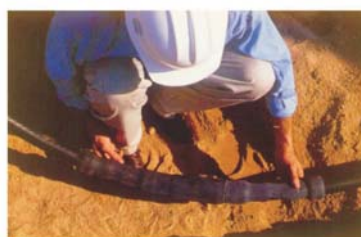
3. 再裝上QS III的外被套管或用防水橡皮膠帶1/2重疊予以包覆
