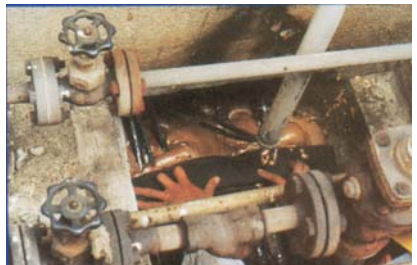
地下配電室管口防水處理
