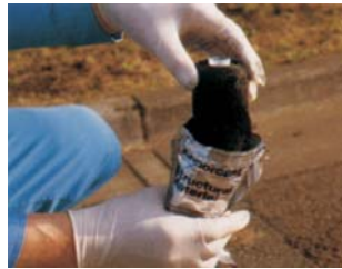
包紮帶完全浸濕後取出
