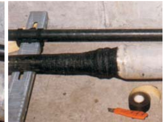
自然固化後即完成
