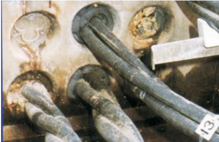
地下人孔內主牆管口防水處理
