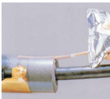
5. 發泡主劑之注入
