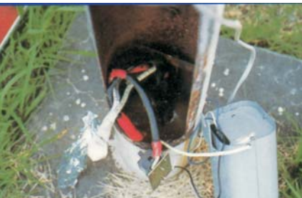
公園路燈燈柱管口防水處理
