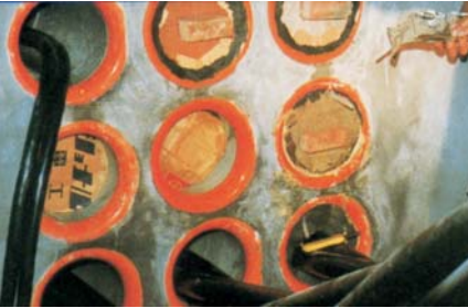
地下人孔內主牆管口之防水及預留管口堵塞處理
