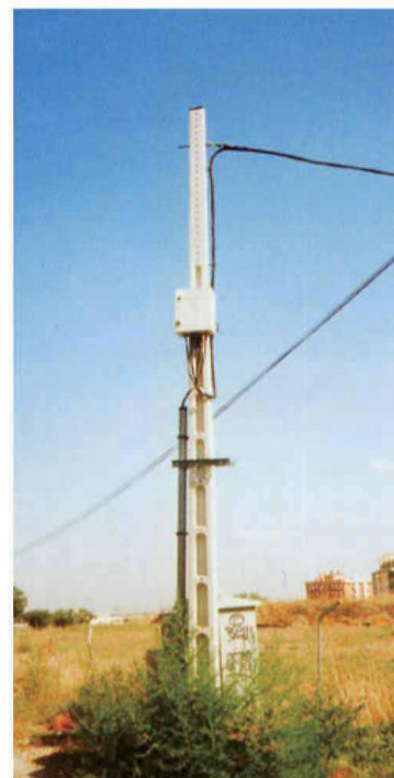
底座含 LV保護裝置的配電盤
