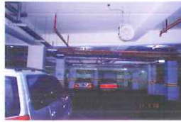
高雄北京建設-陽光情人 B1/B2停車場通風工程
